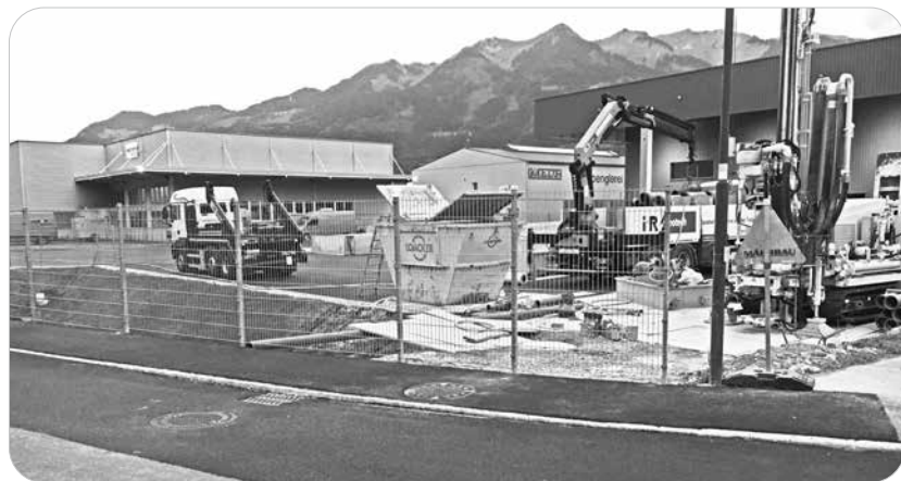
Dieser Gehsteig in der Zementwerkstraße wurde kürzlich fertiggestellt.
