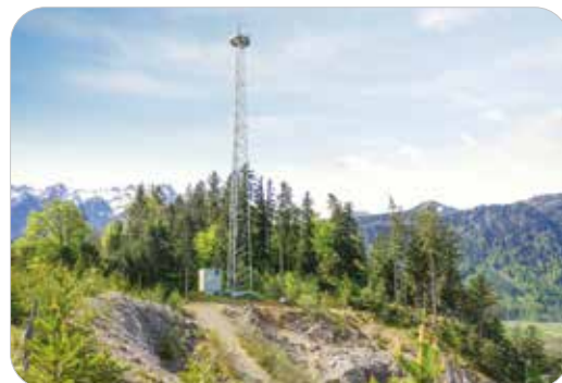
Die neue Funkstation wird an der Spitze des Steinbruchs genau an der Gemeindegrenze auf Nüziger Gebiet errichtet. Fotomontagen: Land Vorarlberg
