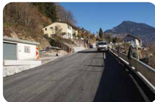
2020 kamen die Bauarbeiten an der L 193 ein gutes Stück voran. Im Herbst soll das Ausbauprojekt abgeschlossen sein.
