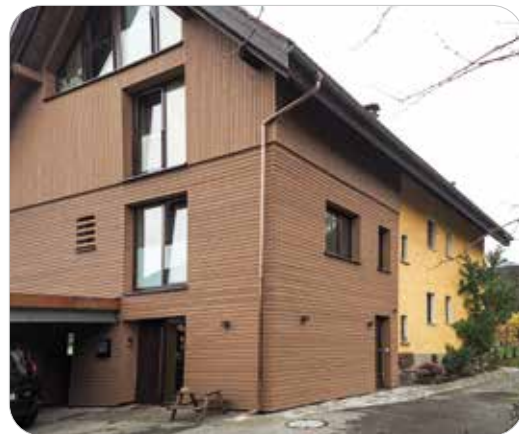
Erfolgreiche Nachverdichtung: Dieses Haus in Göfis bietet nun attraktiven Wohnraum für drei Familien.
